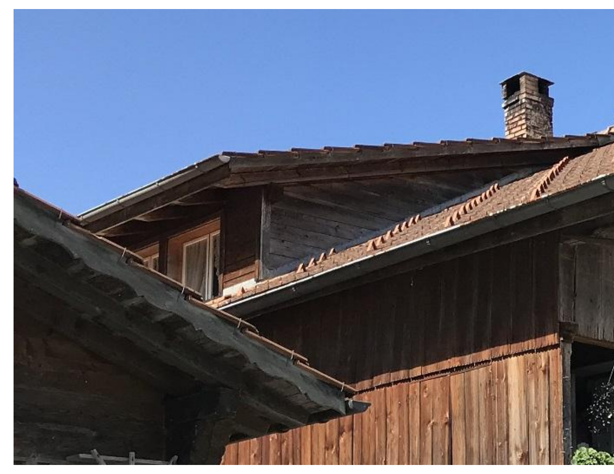
Feld 18 / Dachaufbau (Schlepper)
