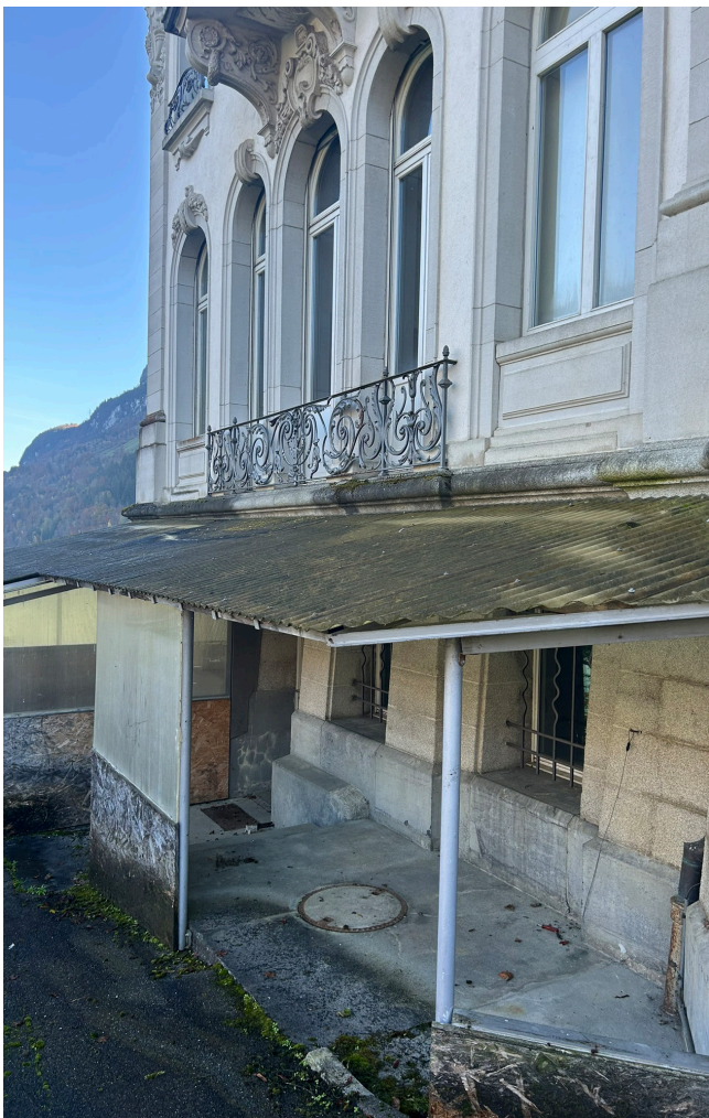
NORD WEST FASSADE
